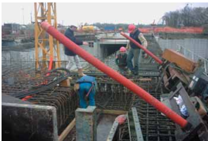
Bétonnage dalle supérieure station Argoulets
