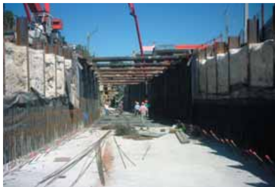
Bétonnage du radier en section tunnel Concreting of foundation raft in tunnel section
