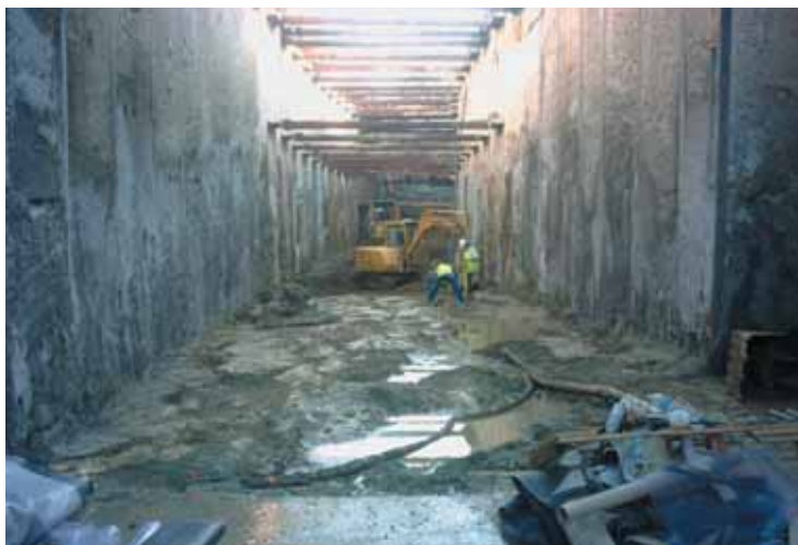
Phase terrassement en section tunnel
