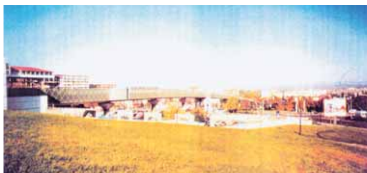
Photo 2 Viaduc Jolimont Jolimont viaduct
